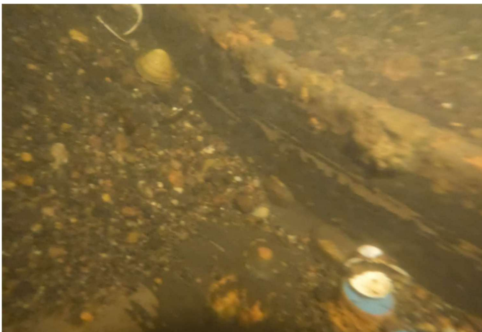
Abbildung 7: Beispielfoto Ablagerungen im Bereich des Drempels Wehrfeld 1
